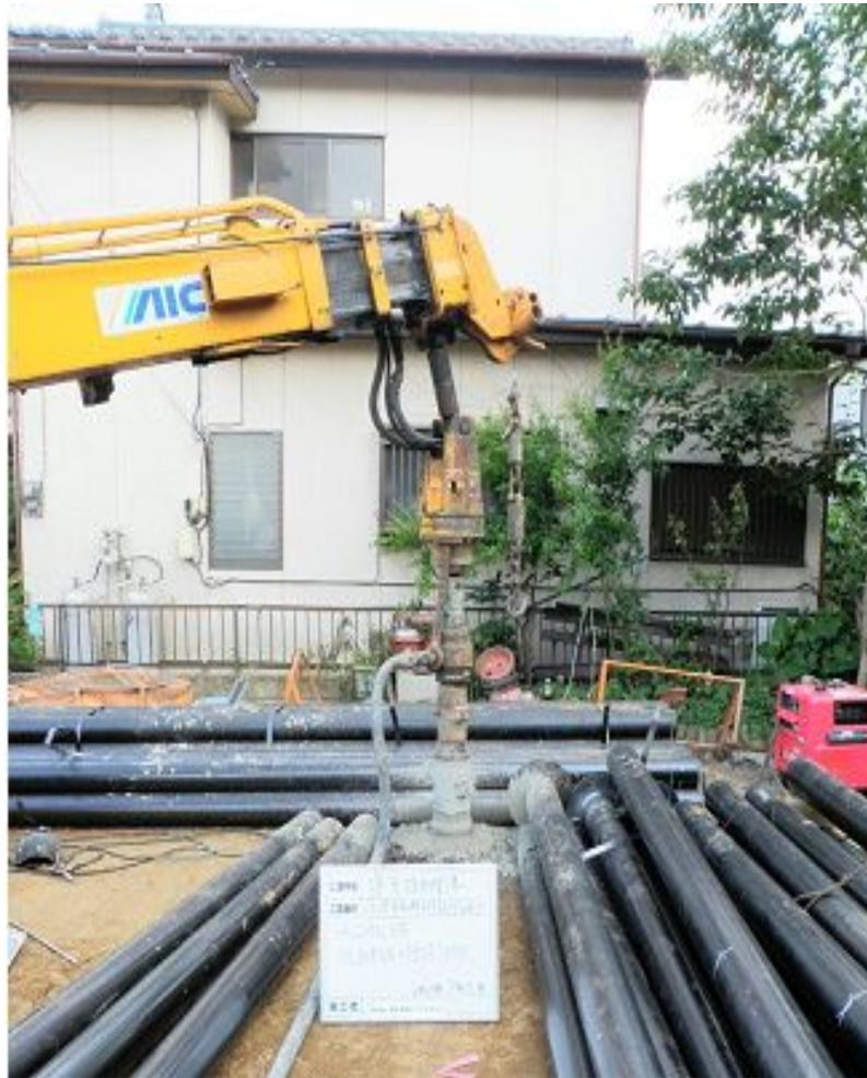
本施工機には、自動記録式回転計・トルク計が設置されています
